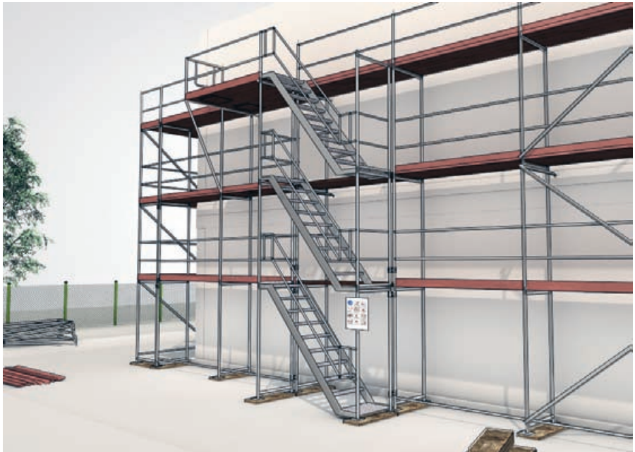
Bild 8: Gerüst mit Gerüsttreppe als Zugang
